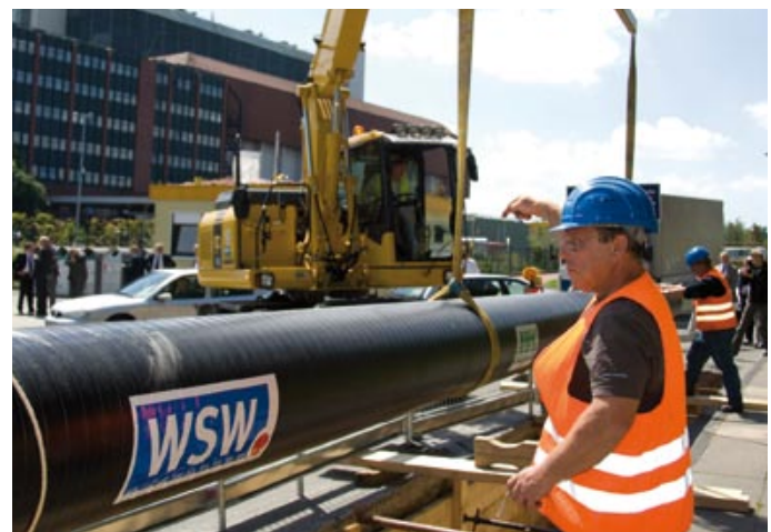
Der Bau der Fernwärmeleitung auf den Wuppertaler Südhöhen
